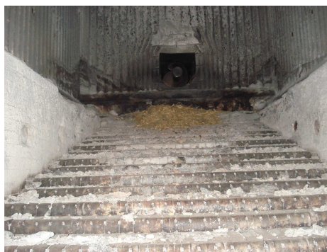
Rys. 2. Zdjęcie ruchomego rusztu Fig. 2. Photo movable stepped grate boiler
