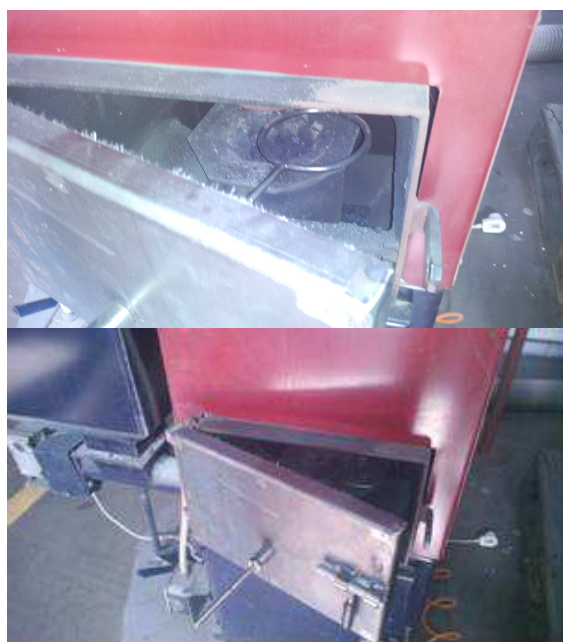
Rys. 2. Modyfikacje w kotle - doprowadzenie dodatkowego paliwa
