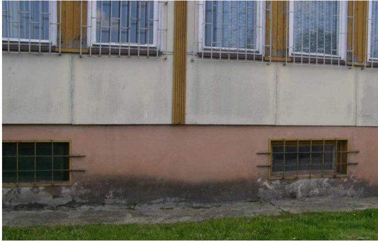
Rys. 1. Budynek dotknięty zjawiskiem podciągania kapilarnego (opracowanie własne)
