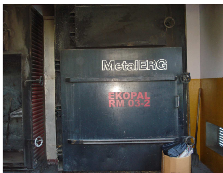
Rys. 1. Zdjęcie kotłów typ wsadowego Fig. 1. Photo of a batch type boilers
